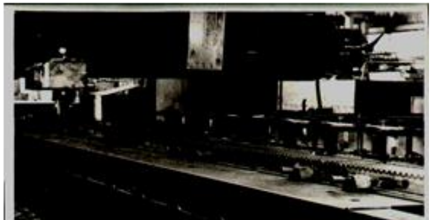
Рисунок 1 – Рейкошевінгування на верстатах із поздовжнім переміщенням столу
