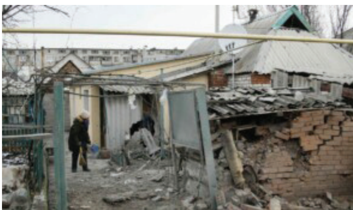
Фото 8. Зруйновані будинки на Донбасі (Джерело: https://zmina.info/news/yak-otrymaty-kompensacziyu-za-zrujnovane-cherez-vijskovi-diyi-zhytlo-instrukciya-vid-minreintegracziyi/ )
